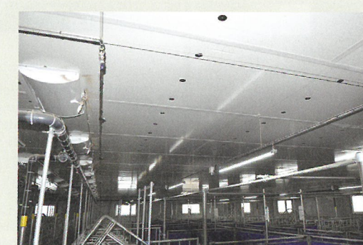
▲ En engraissement, le système de ventilation Exatop d'I-tek a été installé. A noter : la hauteur des portes a été abaissée pour faciliter l'entrée dans les cases et ainsi gagner du temps.
