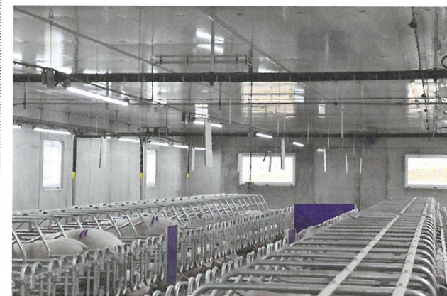
▲ La luminosité dans la nouvelle verraterie de 144 places est maximisée avec de larges fenêtres et des néons LED situés à l'avant et à l'arrière des truies.
