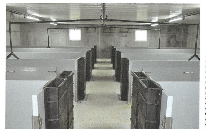
▲ En engraissement, le système de ventilation Exatop d'I-tek a été installé. A noter : la hauteur des portes a été abaissée pour faciliter l'entrée dans les cases et ainsi gagner du temps.
